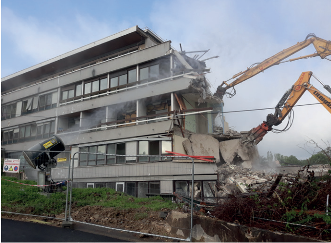
Bâtiment Émile Lannoy sur la ZAC Saint-Jean à Lagny
