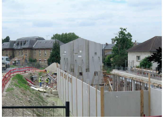
La maison de santé de Marne et Gondoire en construction (site Saint-Jean Lagny)
