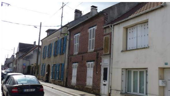
Rue Louis Pasteur sur un secteur étroit
